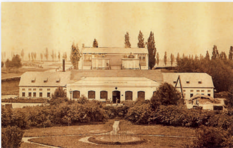
1865 r. – obiekty hutnicze z dwoma wielkimi piecami (pomiędzy budynkiem niskim a wysokim).
